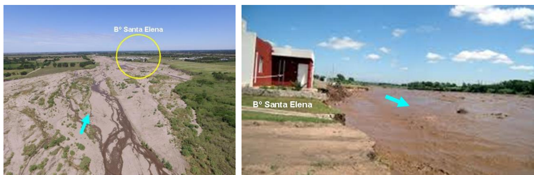
Figura 54. Ampliación del lecho ordinario por erosión de márgenes condicionada por el efecto de avulsión. B° Santa Helena.
