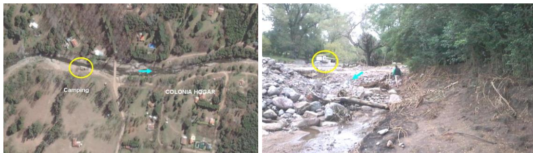
Figura 52. Colonia Hogar. Camping Municipal emplazado en el nivel inferior de terraza activo en forma total en crecidas extremas.
