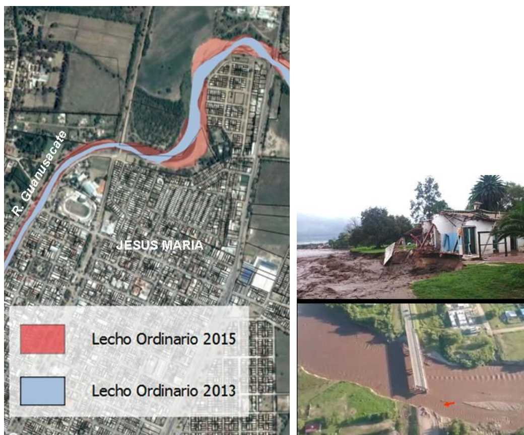
Figura 25. Ciudad de Jesús María ampliación de lecho ordinario (canal) por erosión de márgenes 2013 a 2015. Infraestructura urbana afectada (Bº Agua Mansa) y puente RN 9.
