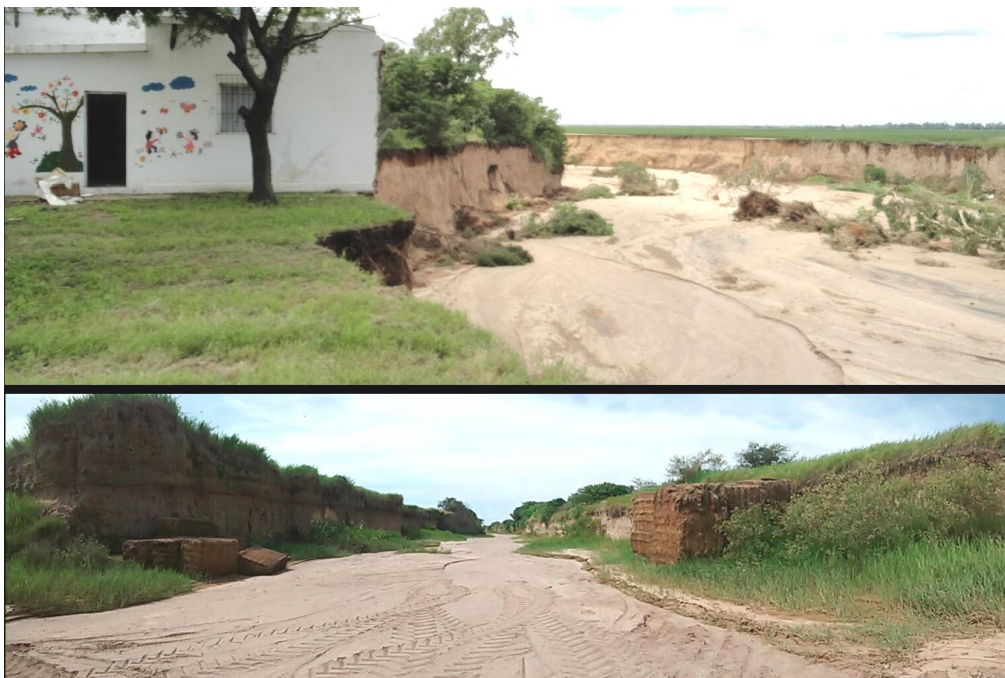
Figura 28. Formación de cauce fluvial a partir de camino rural secundario. Aº Mula Muerta con afectación de escuela Capitán Díaz Vélez.
