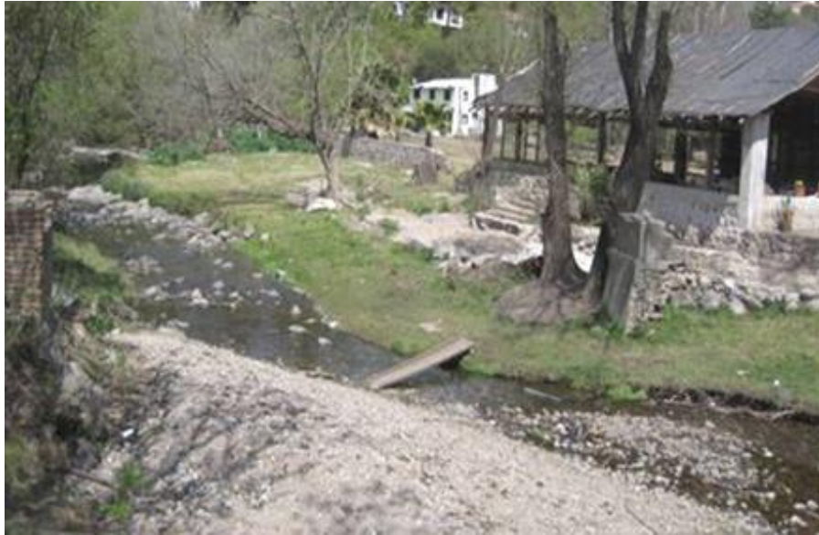
Figura 17. Zona urbana bajo amenaza severa por inundaciones repentinas. Nivel de terraza inundable ante crecidas ordinarias y extremas. La Granja.
